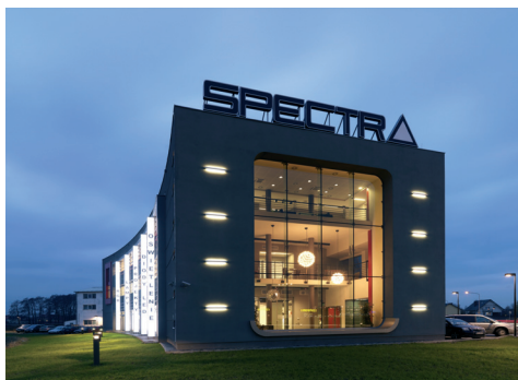
Budynek biurowo-magazynowy Spectra, Warszawa
