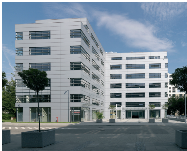
Biurowiec Luminar, Warszawa
