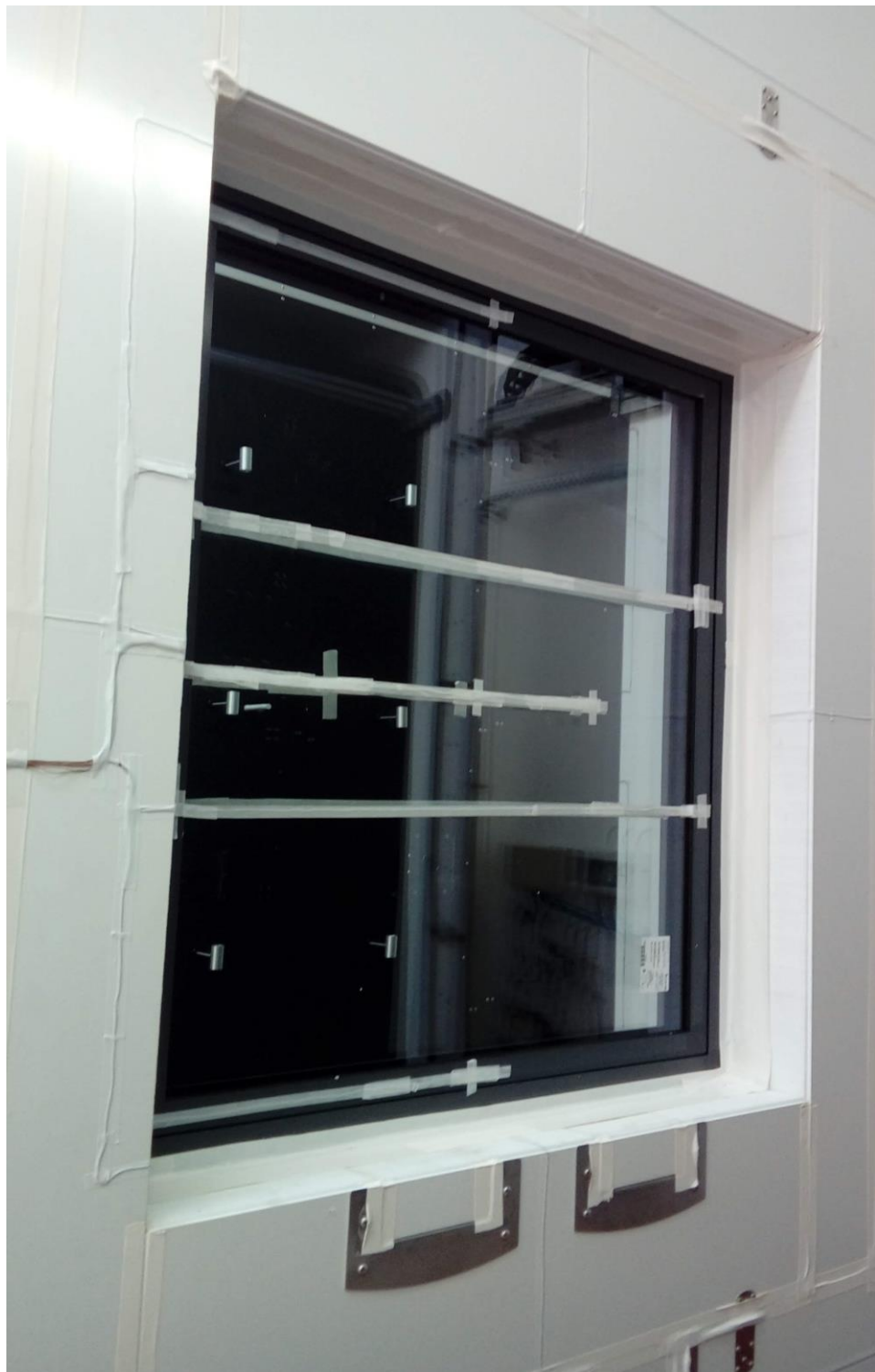
Montaż okna na stanowisku GHB.
